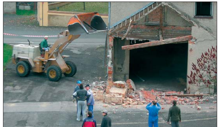
Beginn der Abbrucharbeiten am Feuerwehrgerätehaus Raußlitz durch die Kameraden der Feuerwehr
